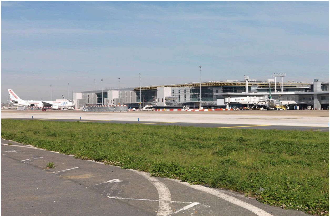
2018, le chantier d'Orly 3 vu depuis le sud est.
