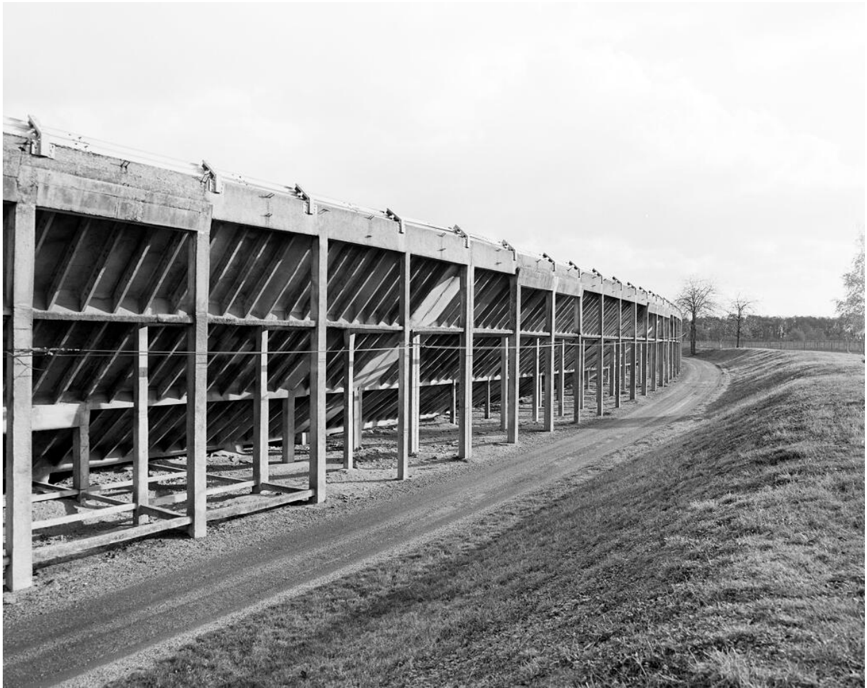
Vue d'ensemble du sous-bassement de l'anneau de vitesse. Autodrome
