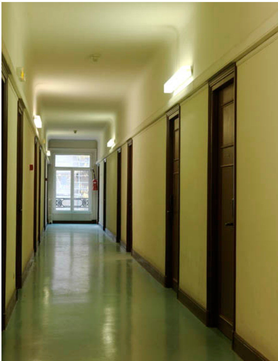
Vue du couloir central desservant les chambres du premier étage.
