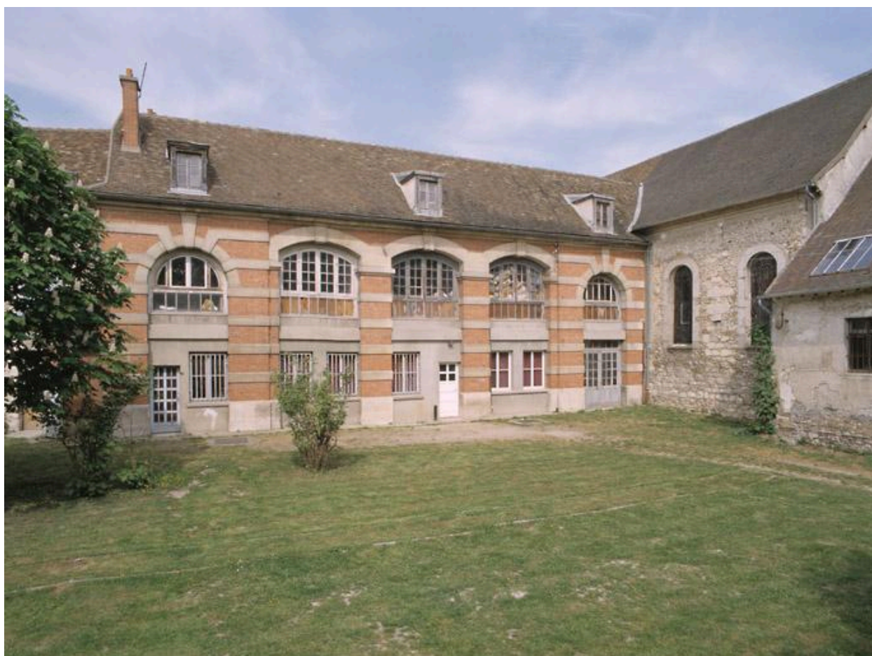
L'orangerie (bâtiment de l'ancien prieuré) accolée au flanc sud de l'église.
