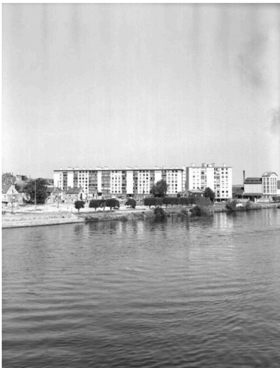
La résidence de la Tour et les bas quartiers en cours de destruction. (Fonds Bertin).
