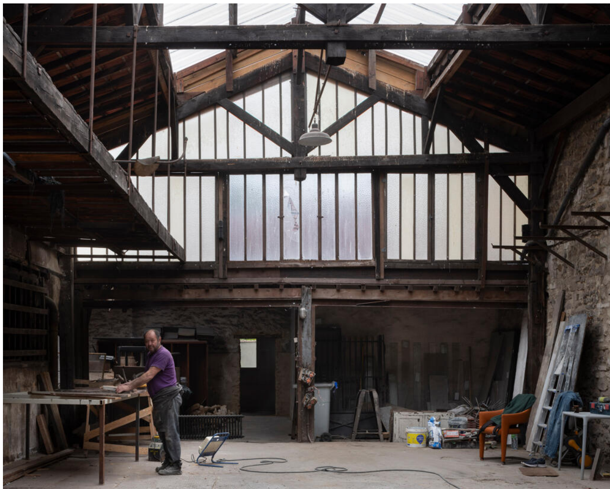
Intérieur de la halle de stockage.
