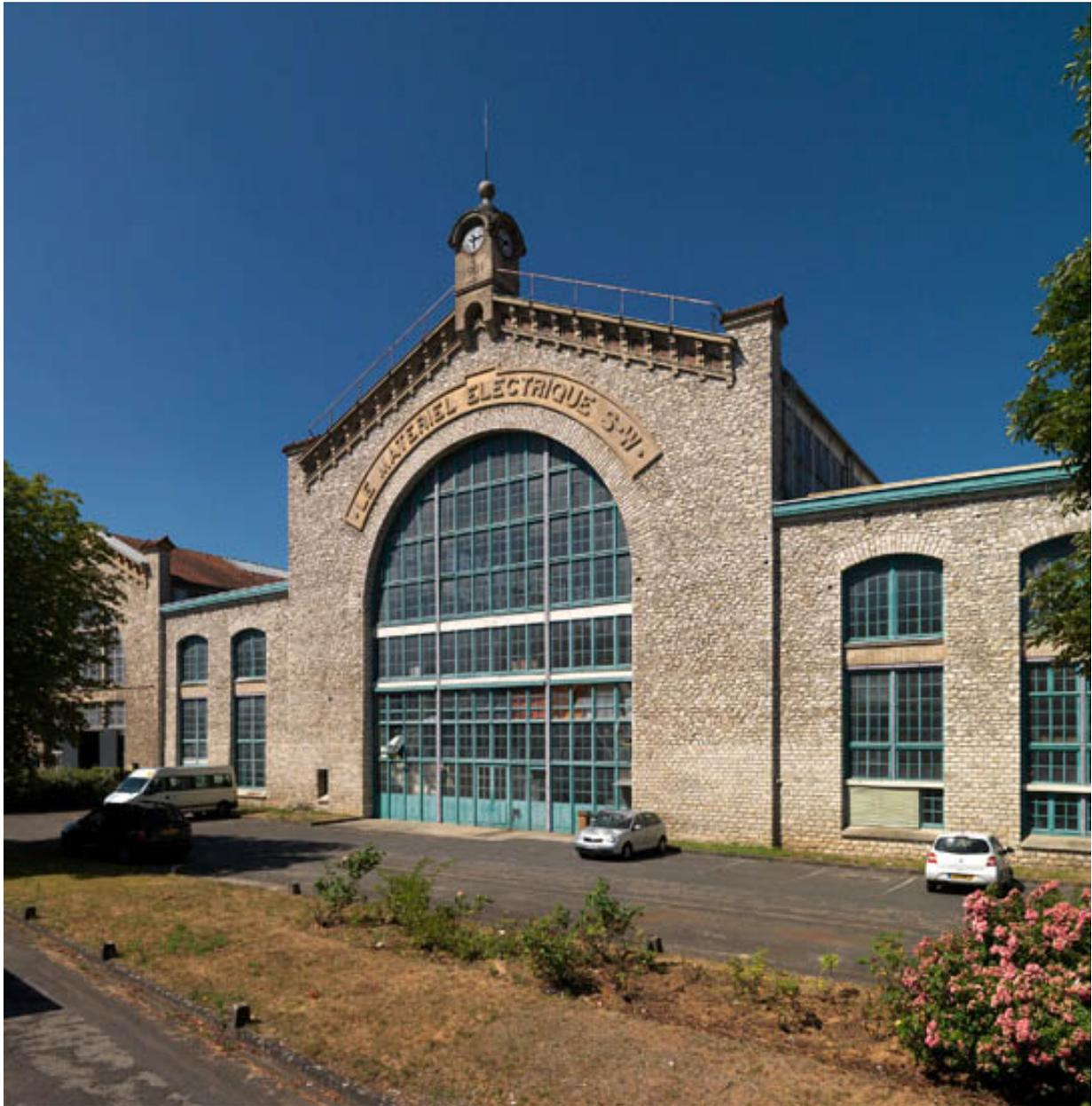
Vue extérieure de l'usine côté voie ferrée. La nef centrale, le pignon monumental, ouvert d'une large baie cintrée, est couronnée d'une double corniche rampante alternant corbeaux et arcades en briques brunes de Montereau.
