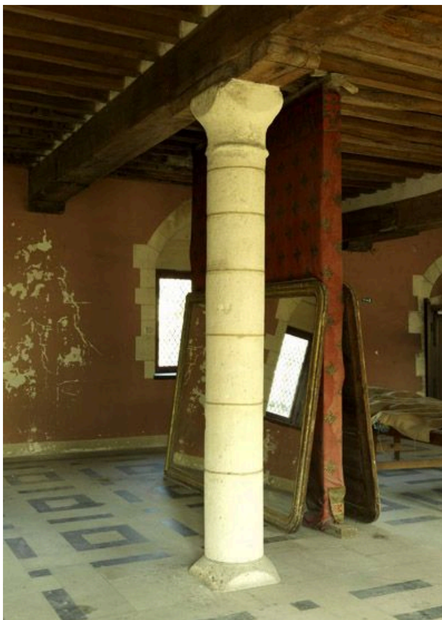
Le premier étage : vue de la colonne sud.
