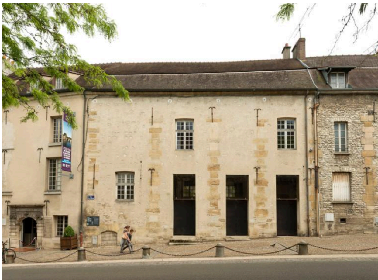
Partie inoccupée des bâtiments.
