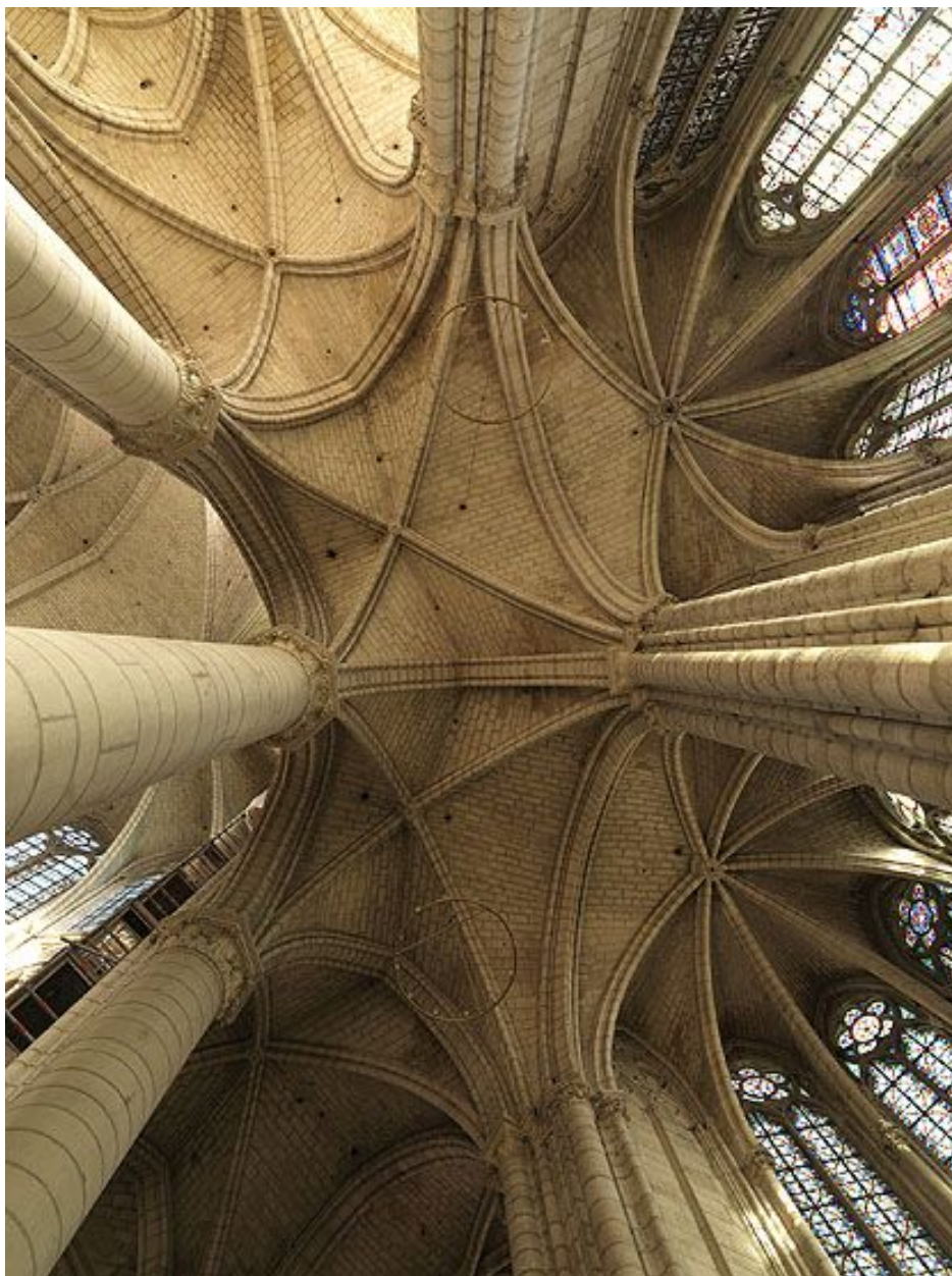
Vue en contre-plongée des voûtes du déambulatoire et des chapelles rayonnantes sud.
