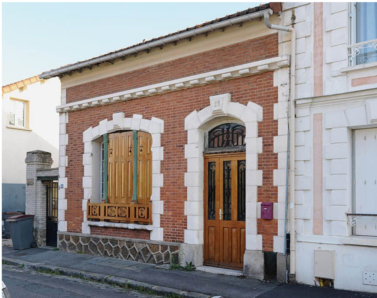
Alfortville, maison, 28 rue Raspail. Vue générale.
