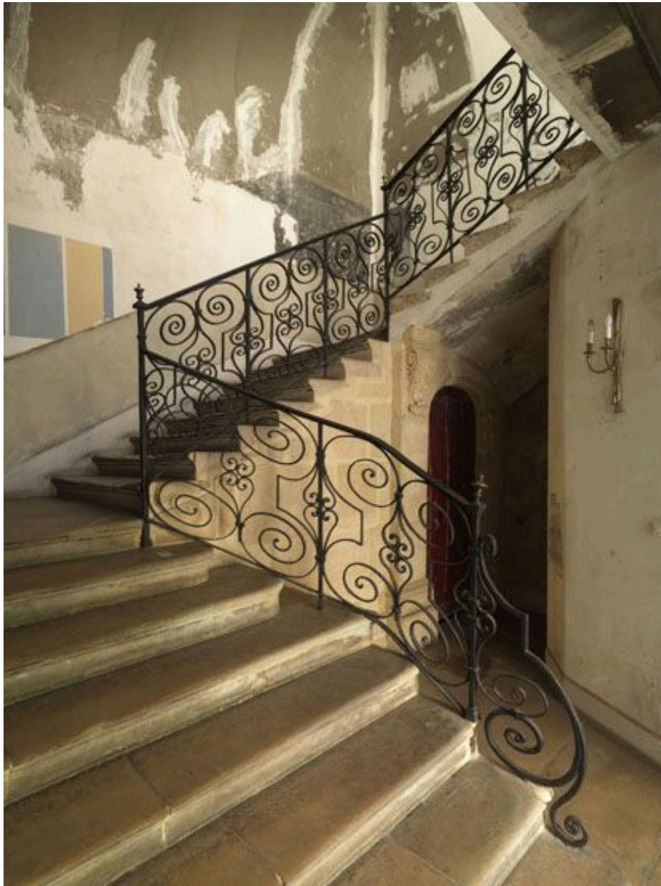
Vue du départ de rampe.
