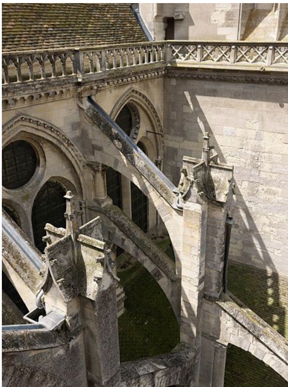
Parties hautes : détail des fenêtres hautes et des arcs-boutants de la nef, côté nord.
