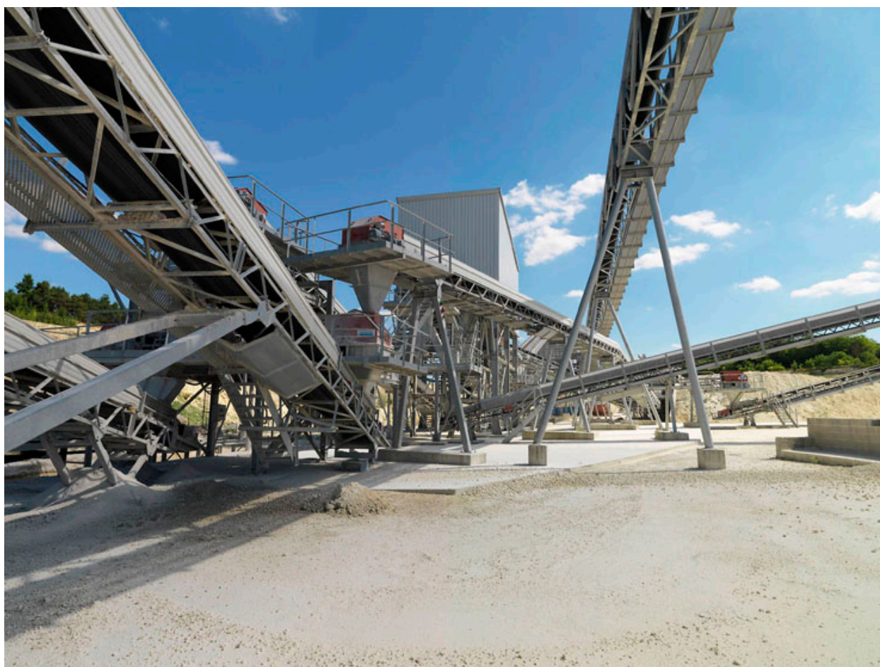
Plateforme - installation secondaire.
