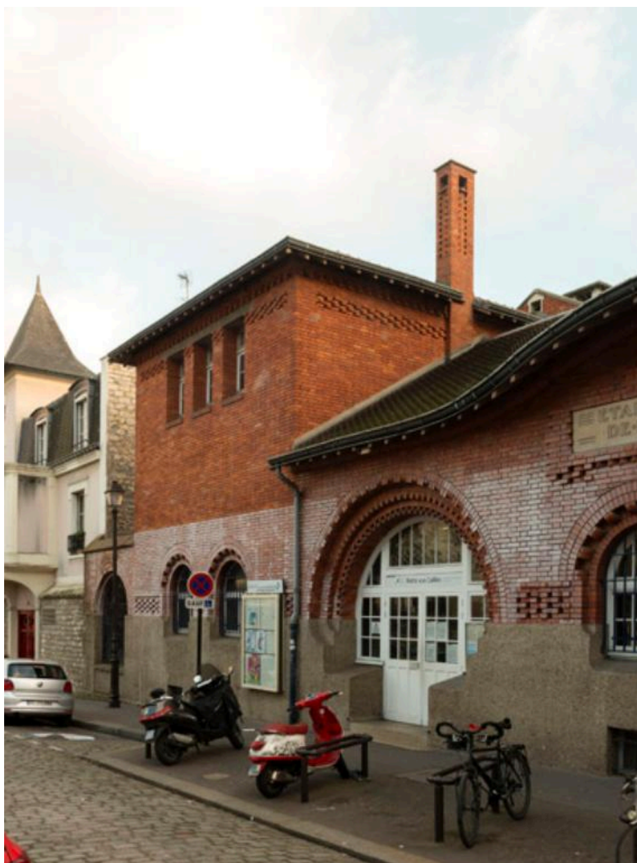
Détail de l'aile latérale contenant les bains-douches, accolée à la piscine de la Butte-aux-Cailles (Paris, 13e).
