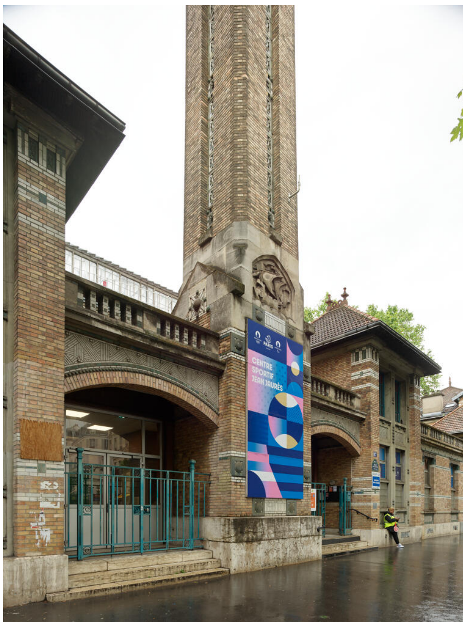
Le gymnase Jean Jaurès.
