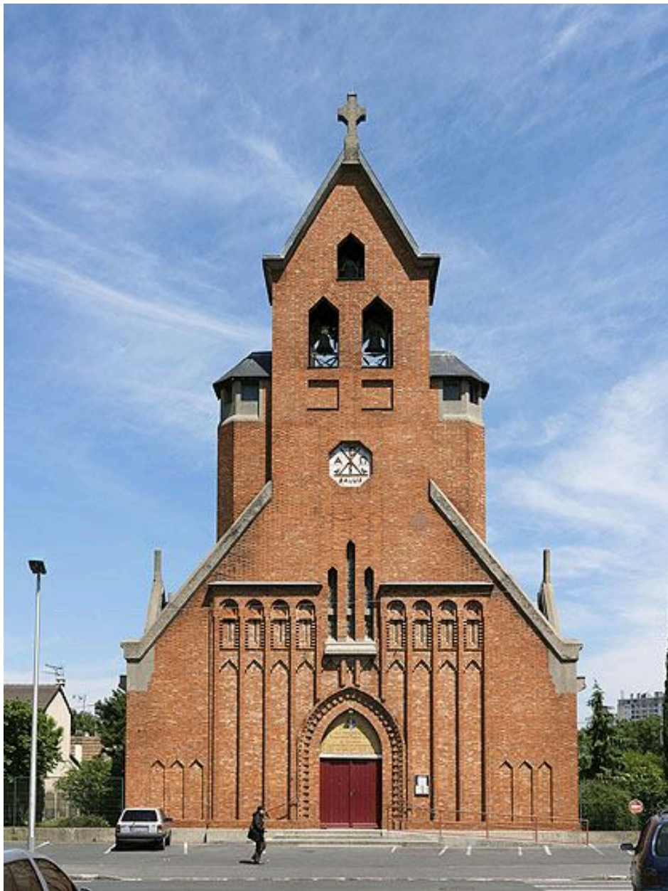
93, Blanc-Mesnil (Le), église paroissiale Saint-Charles, avenue du Capitaine-René-Fonck. Elévation générale de la façade.
