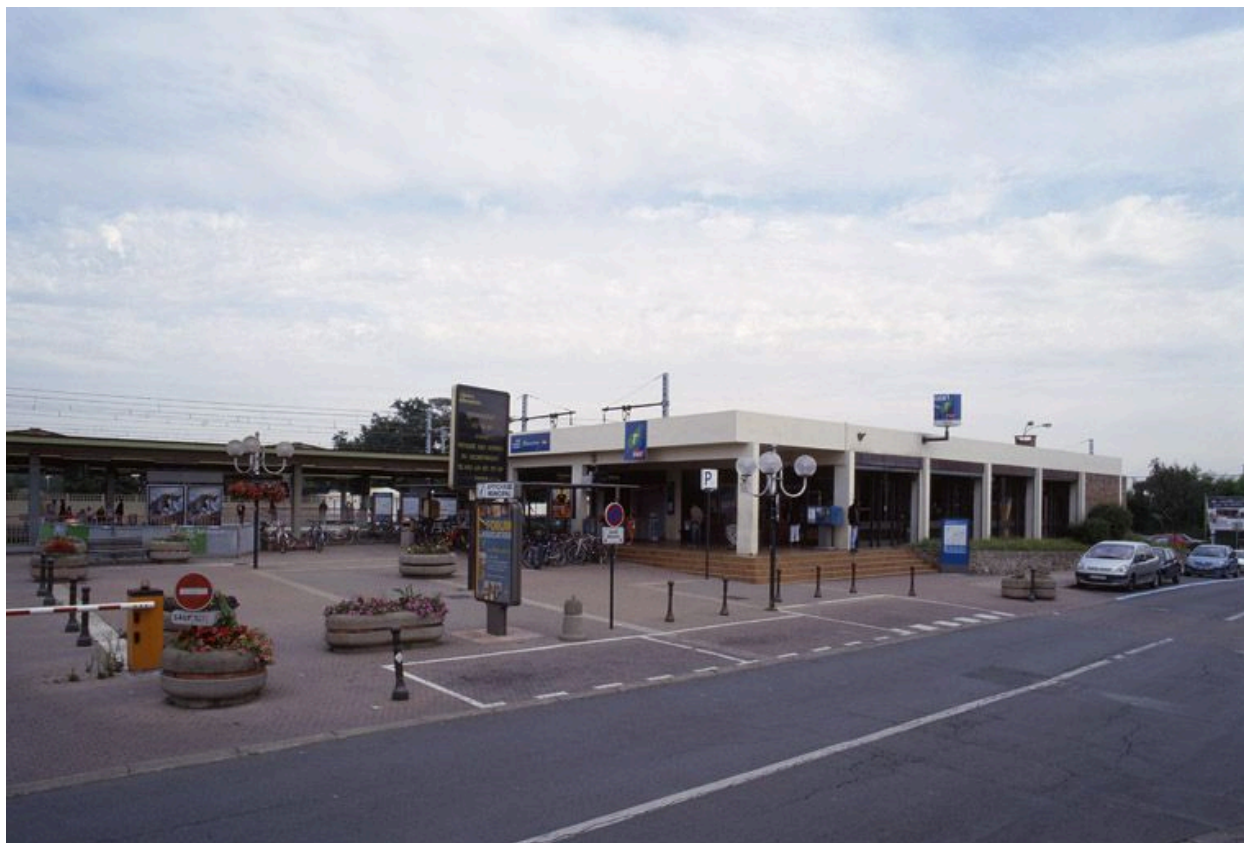
Vue d'ensemble du bâtiment voyageurs.
