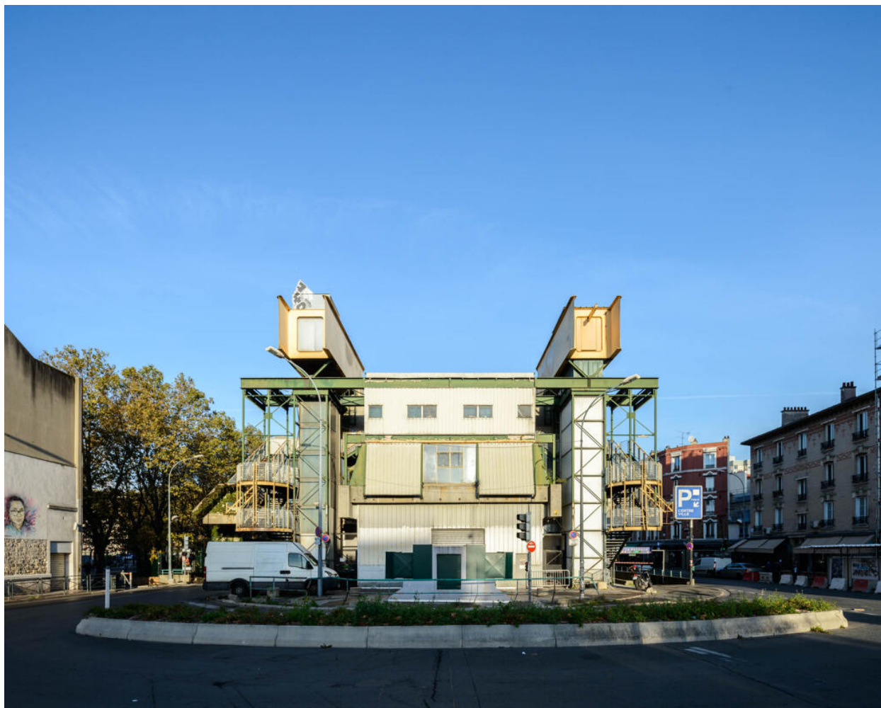
Patinoire de Saint-Ouen. Façade postérieure.
