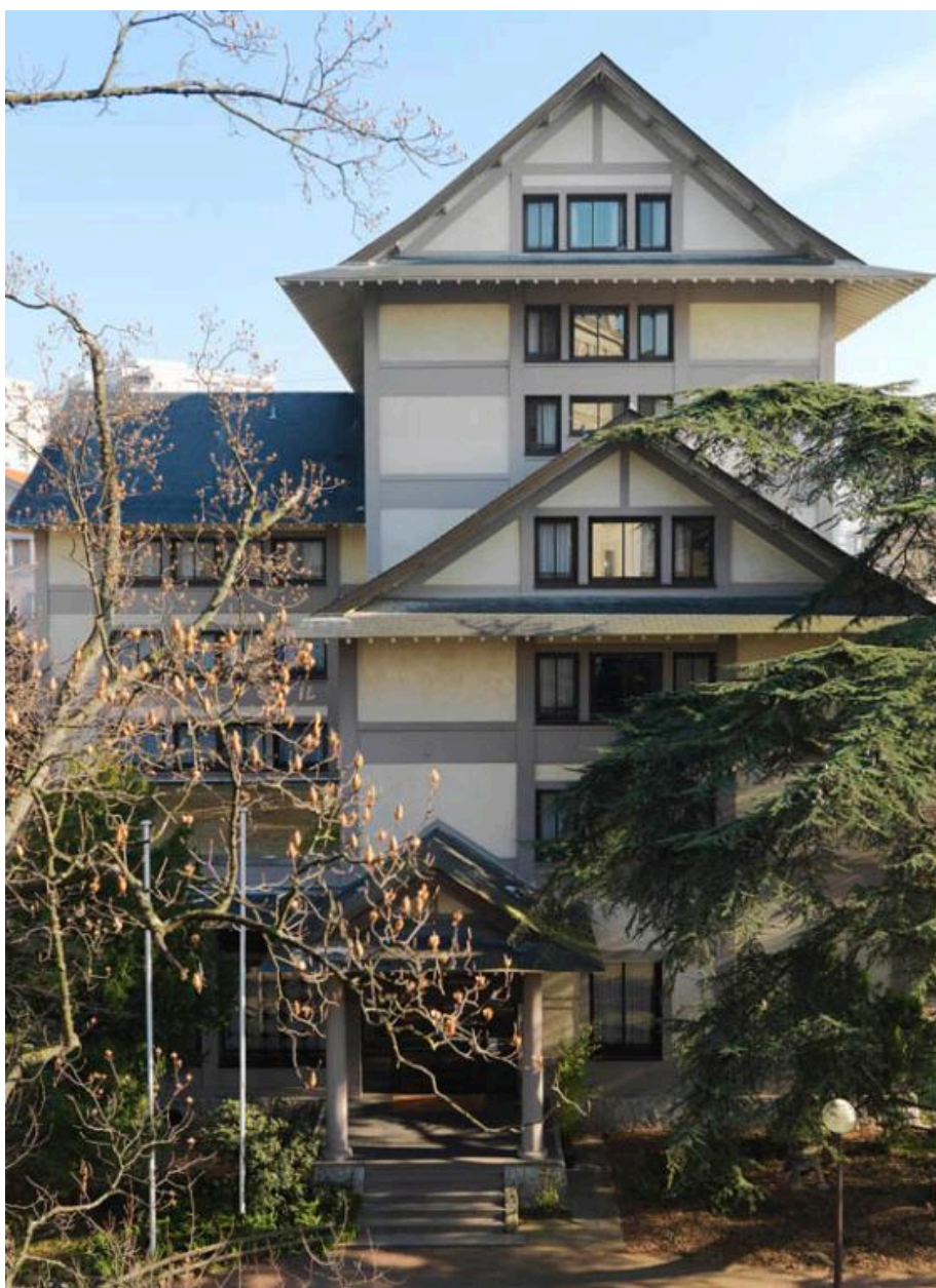
Vue générale du bâtiment.
