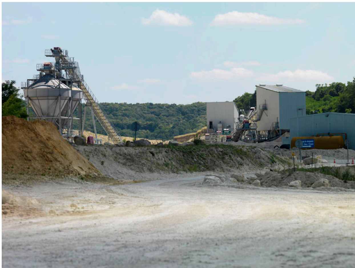
Ancienne centrale de malaxage.
