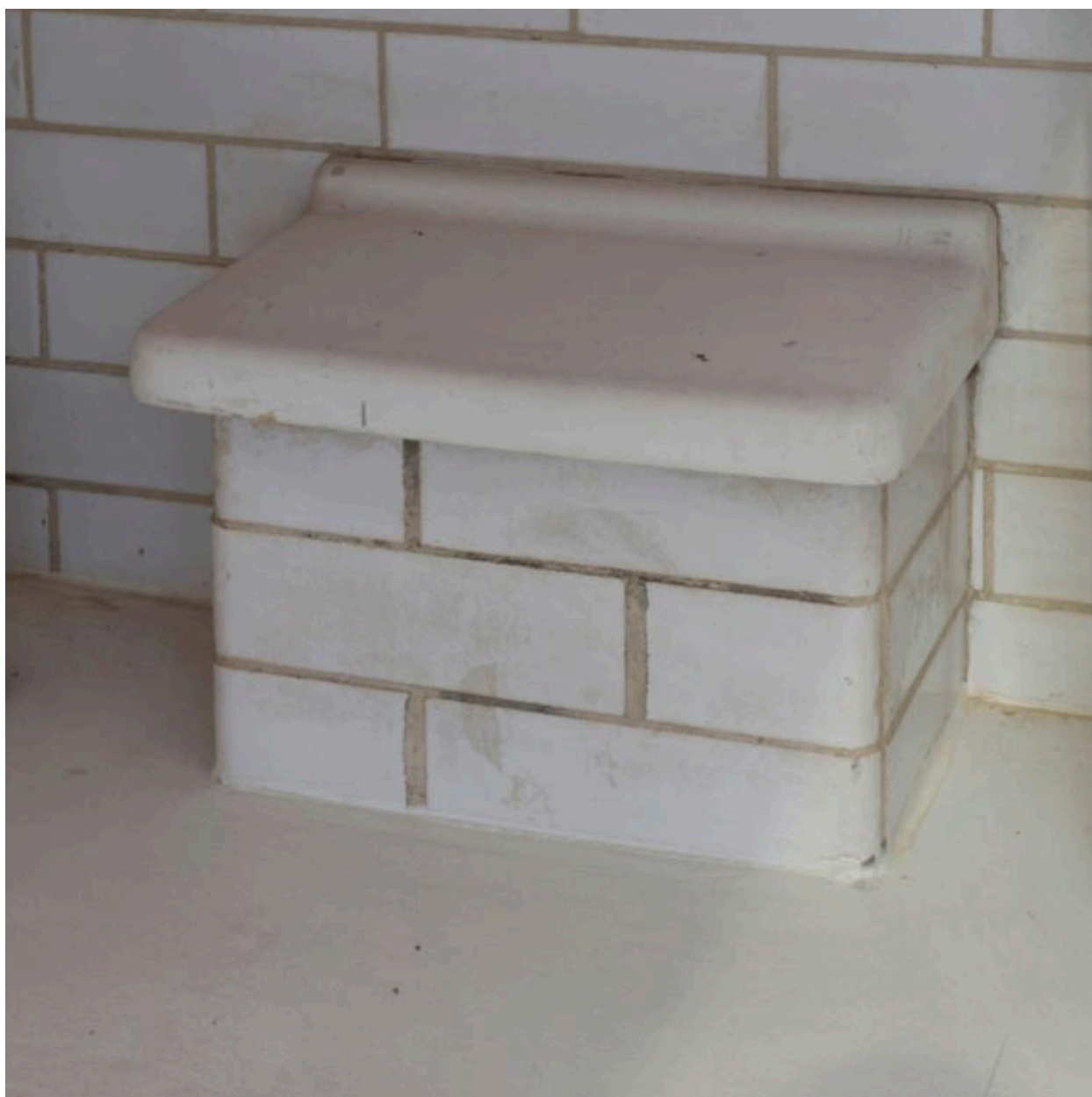
Siège en ciment dans une cabine de douche.
