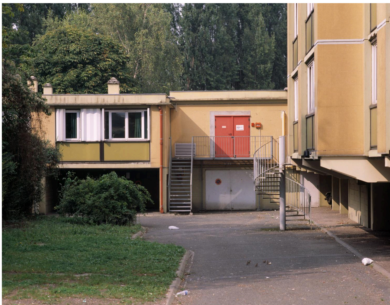
Vue du bâtiment de la chaufferie et du logement des gérants situé sur la façade postérieure, derrière l'entrée.
