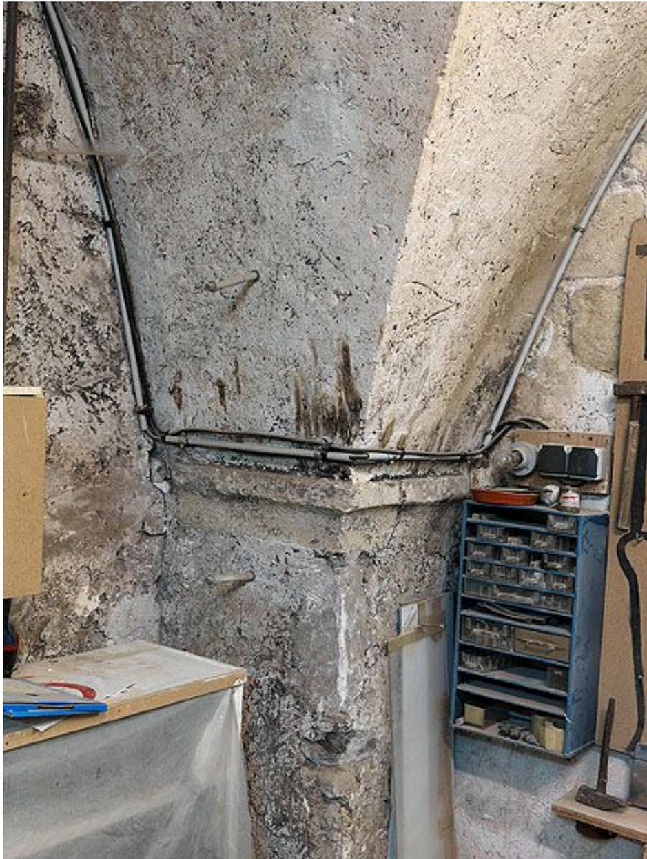
Premier niveau de cave, salle occidentale (entre le "vestibule" et la partie en berceau à arcs doubleaux) : détail du pilastre accueillant la retombée de la voûte d'arêtes.
