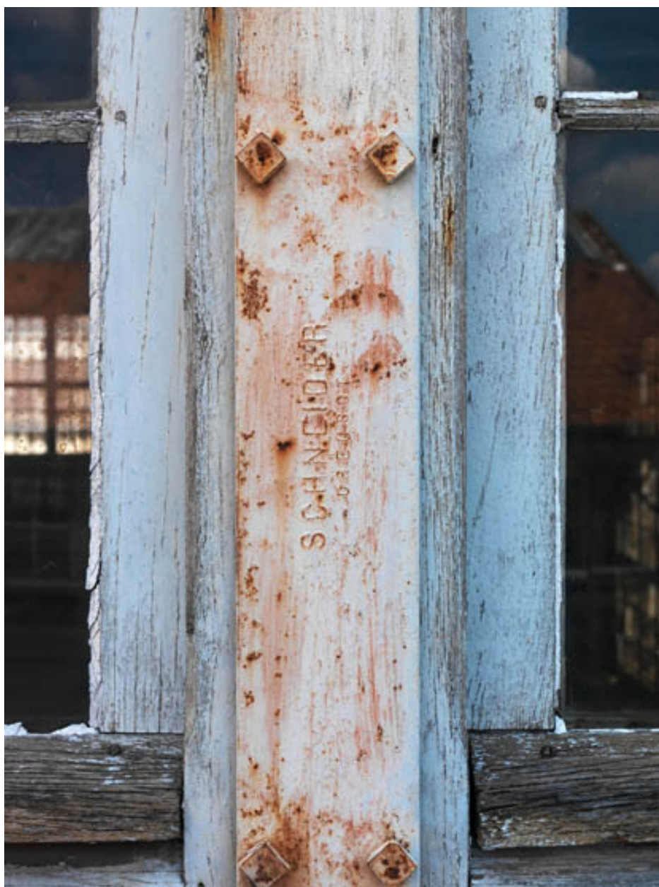
Détail de la charpente métallique conçue par les ateliers Schneider & Cie de Chalon-sur-Saône.
