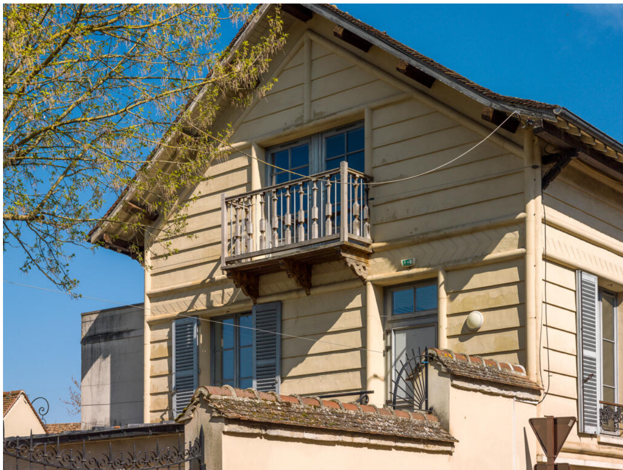
Détail du pignon ouest du 45 rue Langlois.
