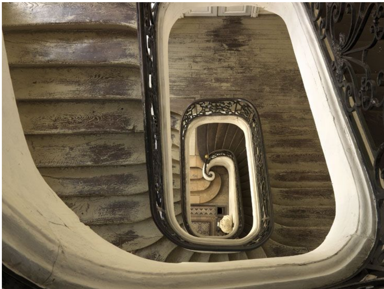
Vue du vide central en plongée.
