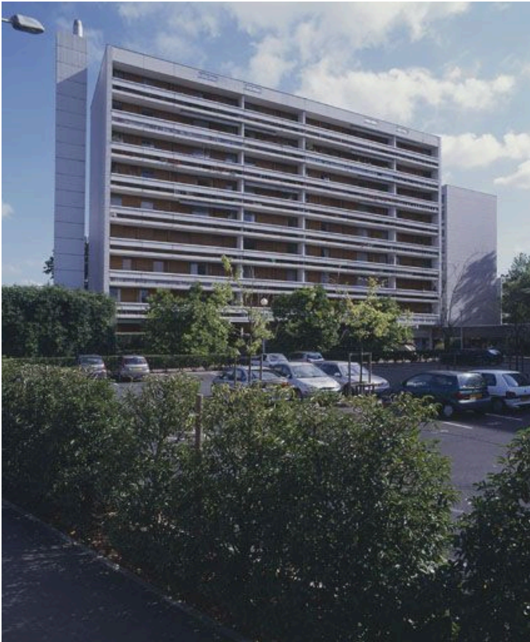
Vue d'ensemble de l'immeuble perpendiculaire à l'allée des Collèges (au nord de la résidence), un des quatre immeubles R+8.
