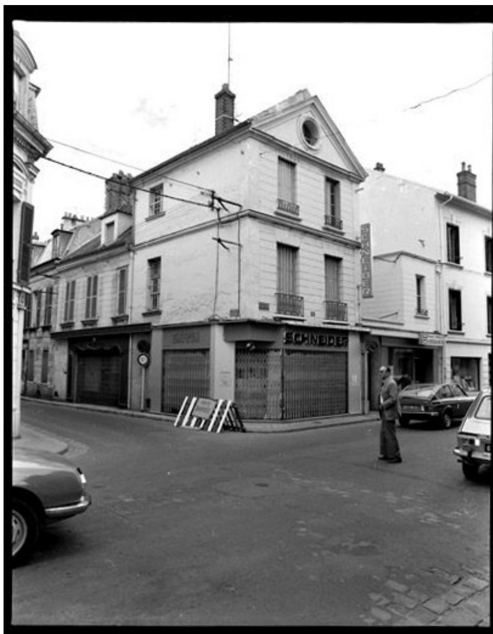
Maison, Gambetta (rue) 12. Vue d'ensemble.
