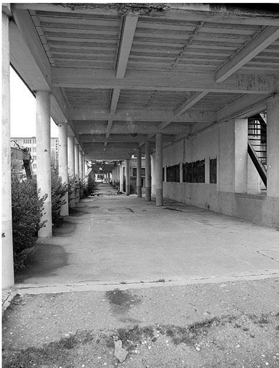
Portique des bâtiments A. Campagne photographique, lors de la destruction du bâtiment en 1976.
