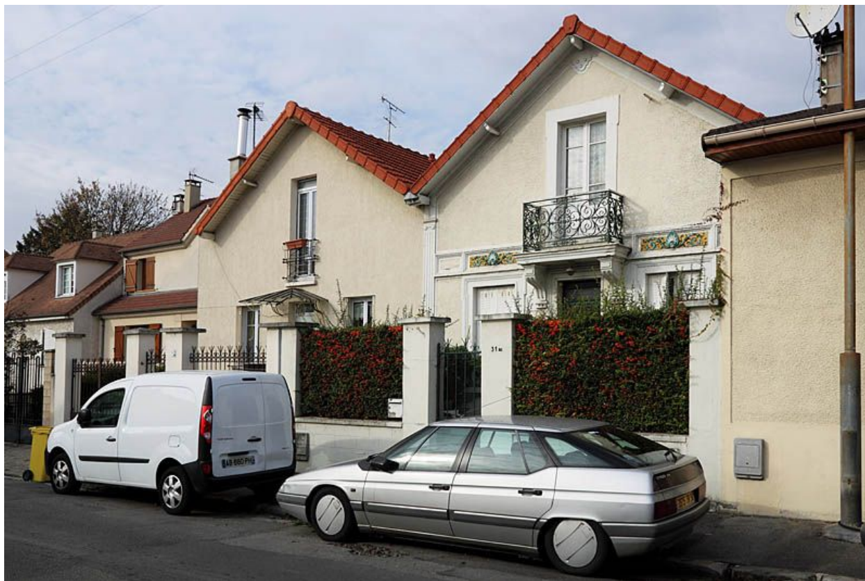
Alfortville, maison jumelée, 31, 31 bis rue des Pivoines. Vue générale.
