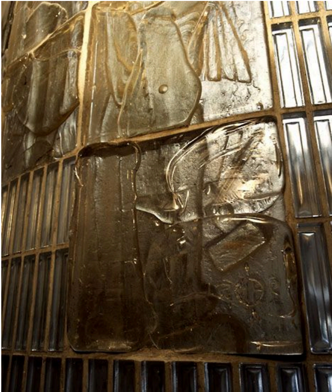
92 - Montrouge, Jean-Jaurès (avenue) 128, lycée professionnel du bâtiment, verrière figurée. Autre détail de la verrière de l'escalier, réalisée en verre moulé, en 1954 par Henri Navarre.
