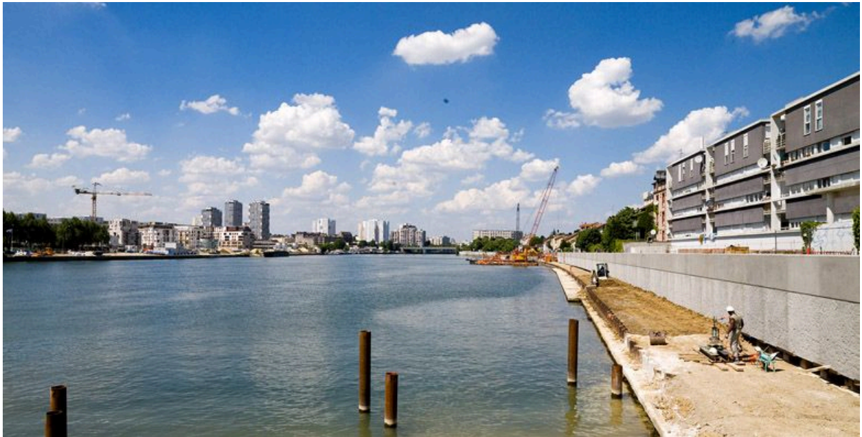
Choisy-le-Roi. Travaux le long de la berge, quai des Gondoles. Au loin les tours du centre-ville.
