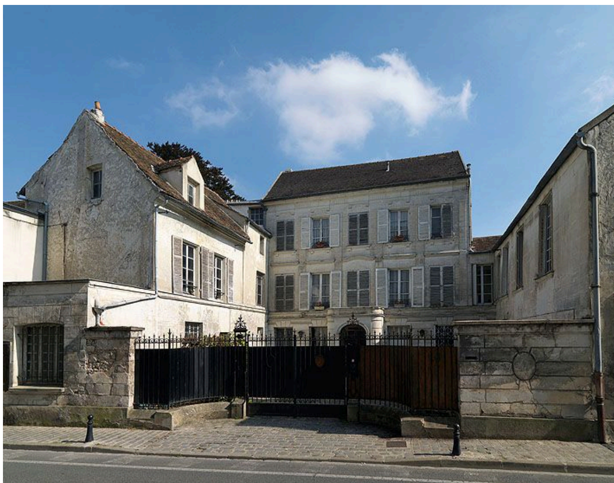
Ancienne maison canoniale, 24-24bis rue Notre-Dame, remaniée au XIXe siècle : vue d'ensemble, avec les communs et la grille d'entrée.
