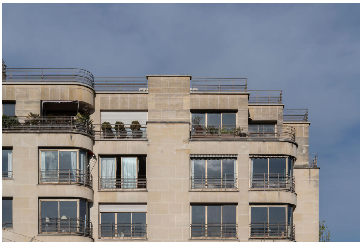
Ensemble des Gâte-Ceps, partie supérieure de l'aile nord : terrasses et garde-corps caractéristiques de l'architecture paquebot
