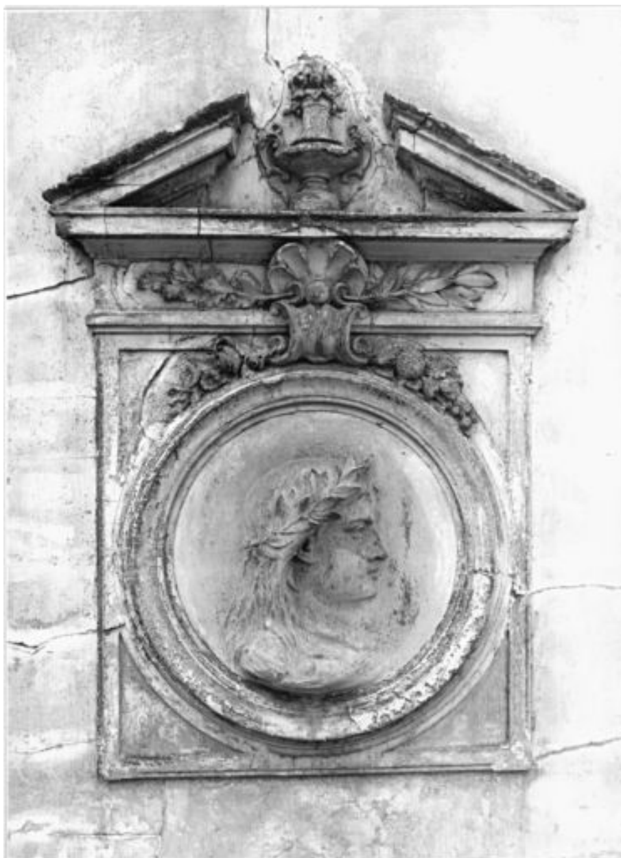
Détail de la facade antérieure, aile gauche.
