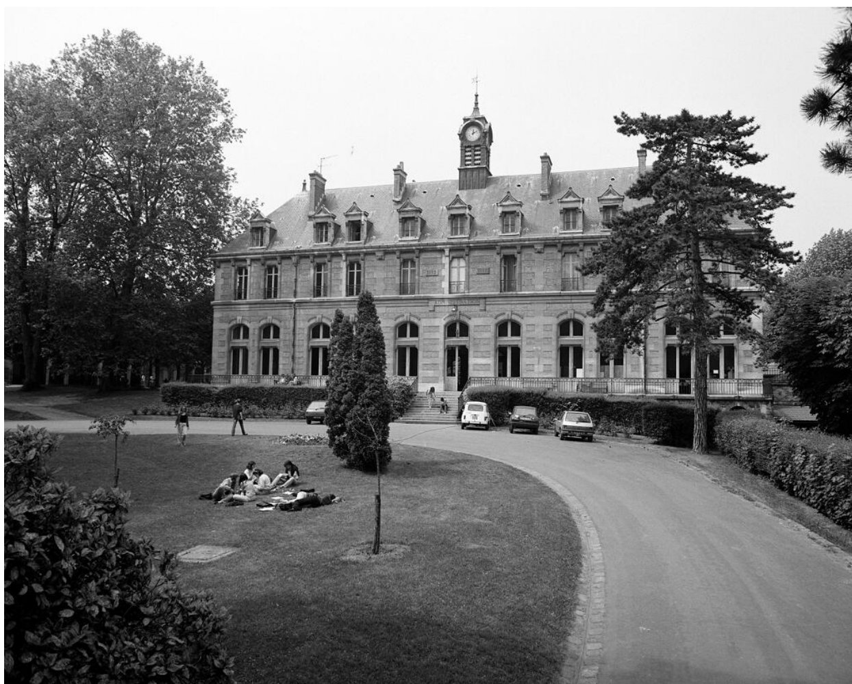
Bâtiment d'administration : la façade principale (est). Lycée dit Lycée Lakanal
