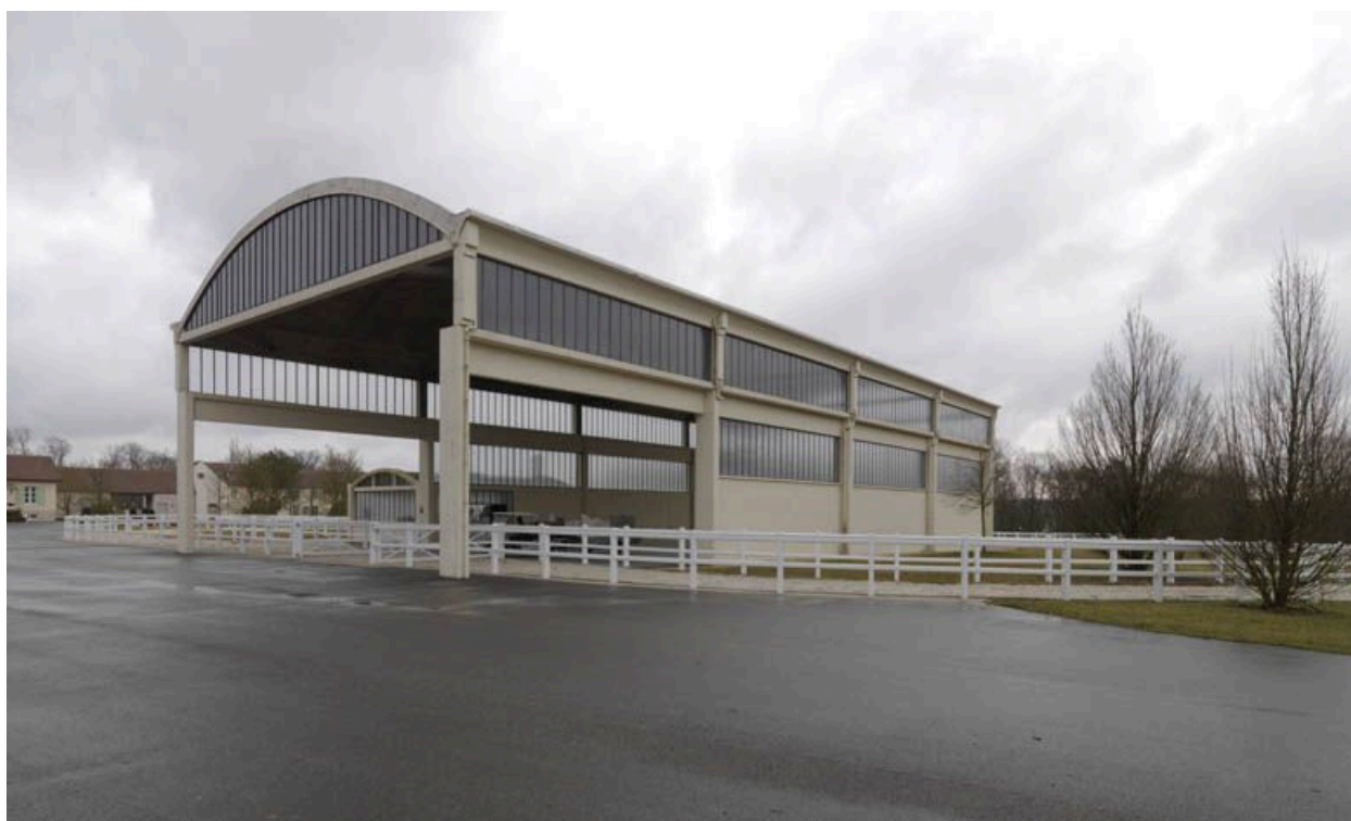
Halle en béton ayant abrité le banc de sciage. Vue d'ensemble.
