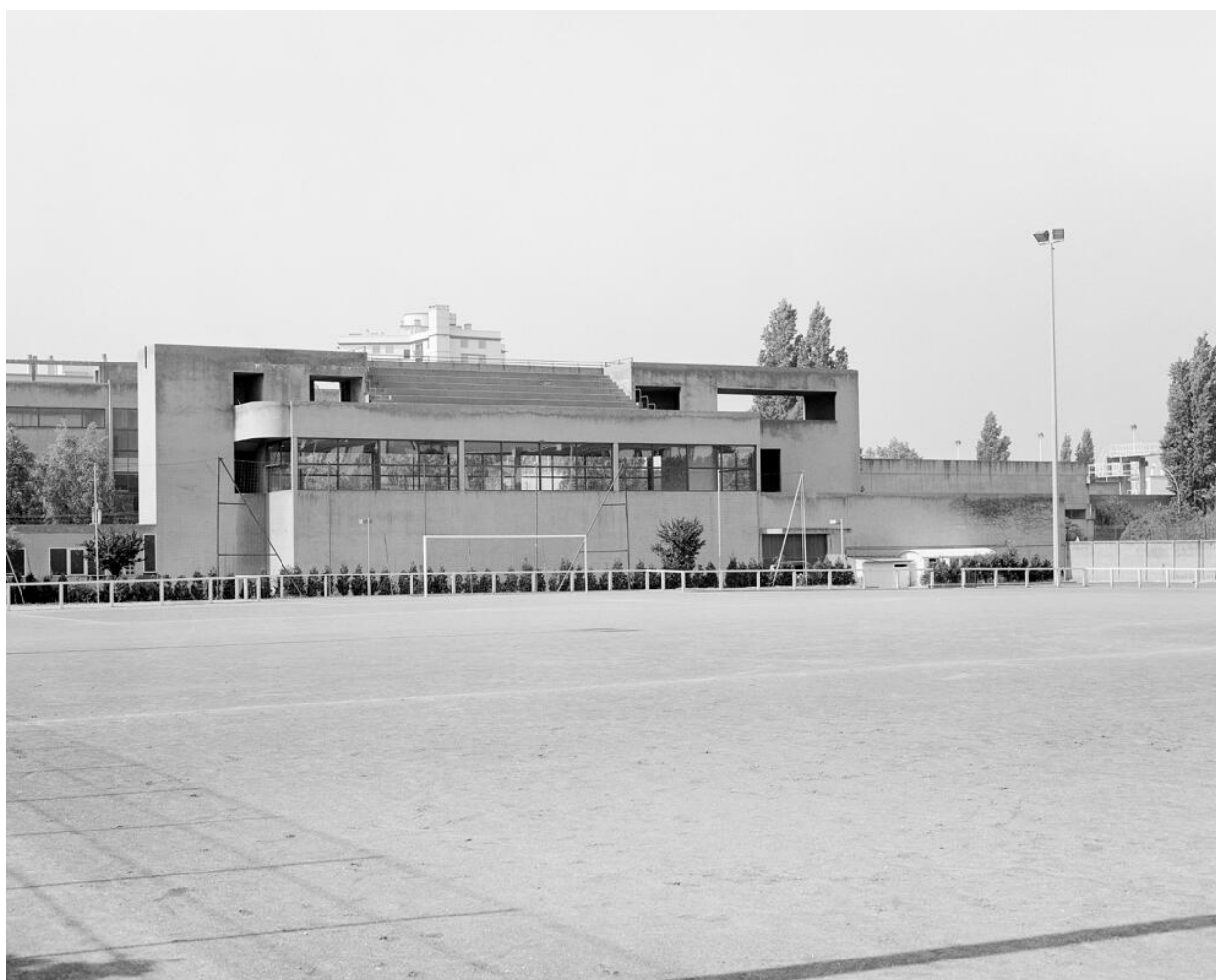
Vue du gymnase, prise de l'intérieur du stade. Groupe scolaire dit groupe scolaire Karl-Marx
