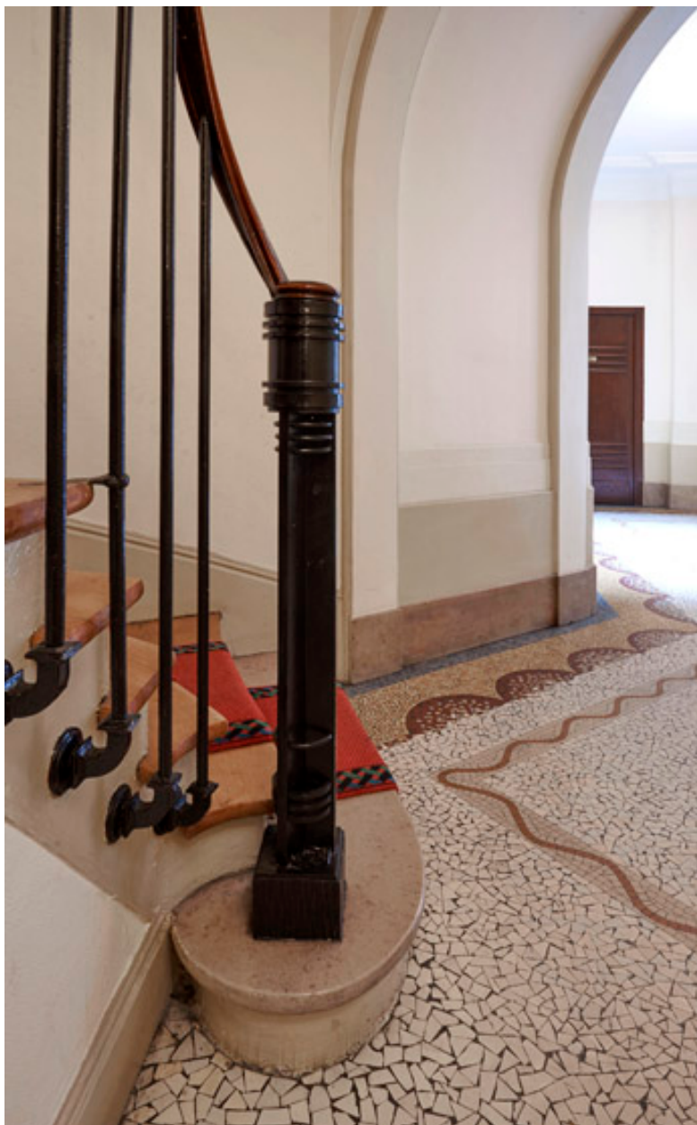
Départ de l'escalier du n°4.
