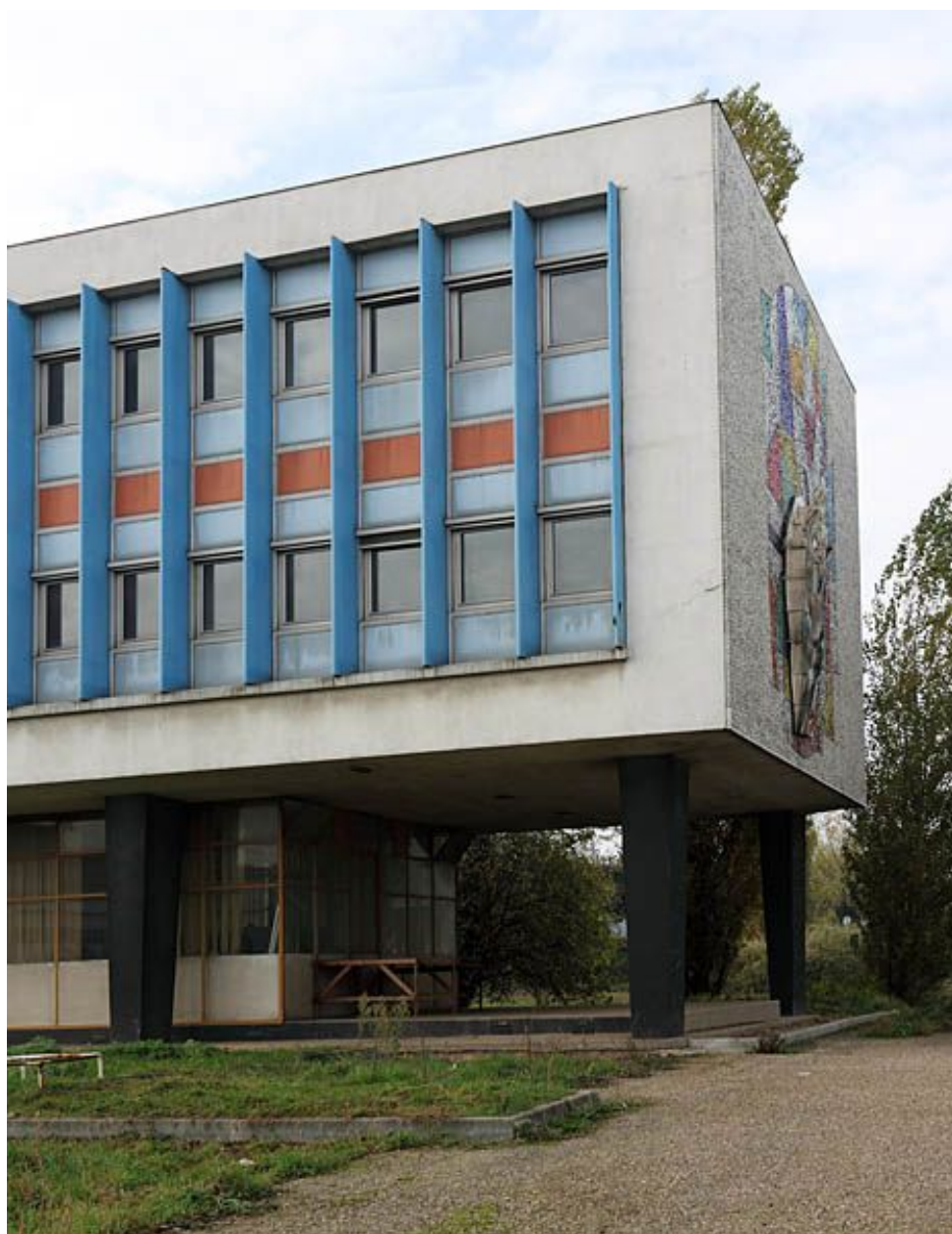
Alfortville, usine à gaz, quai d'Alfortville. Vue rapprochée du bâtiment administratif orné de la mosaïque de Fernand Léger. Photographie, 2011.
