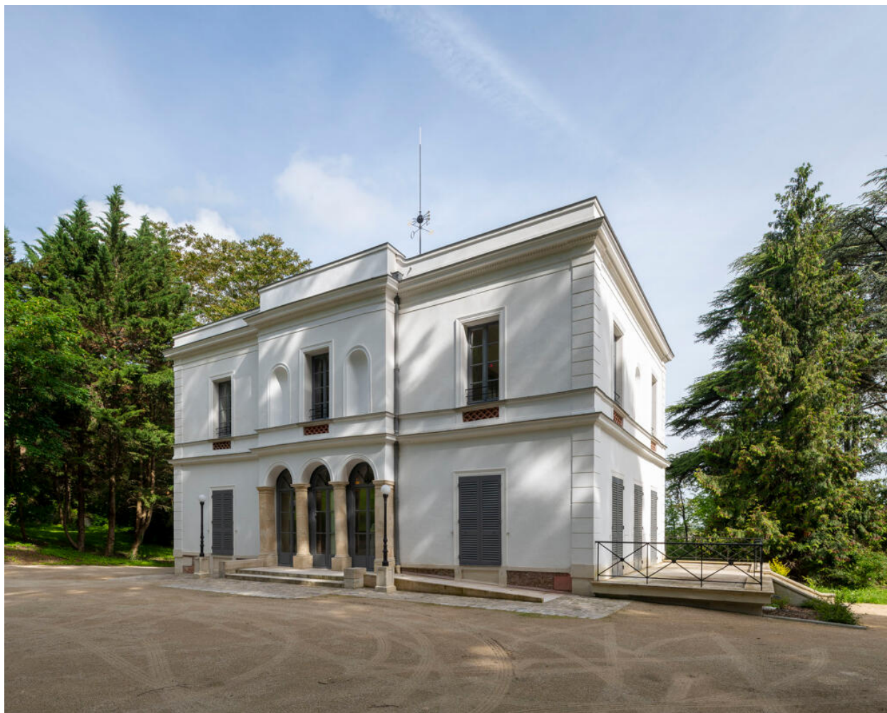
Vue de la façade sud.
