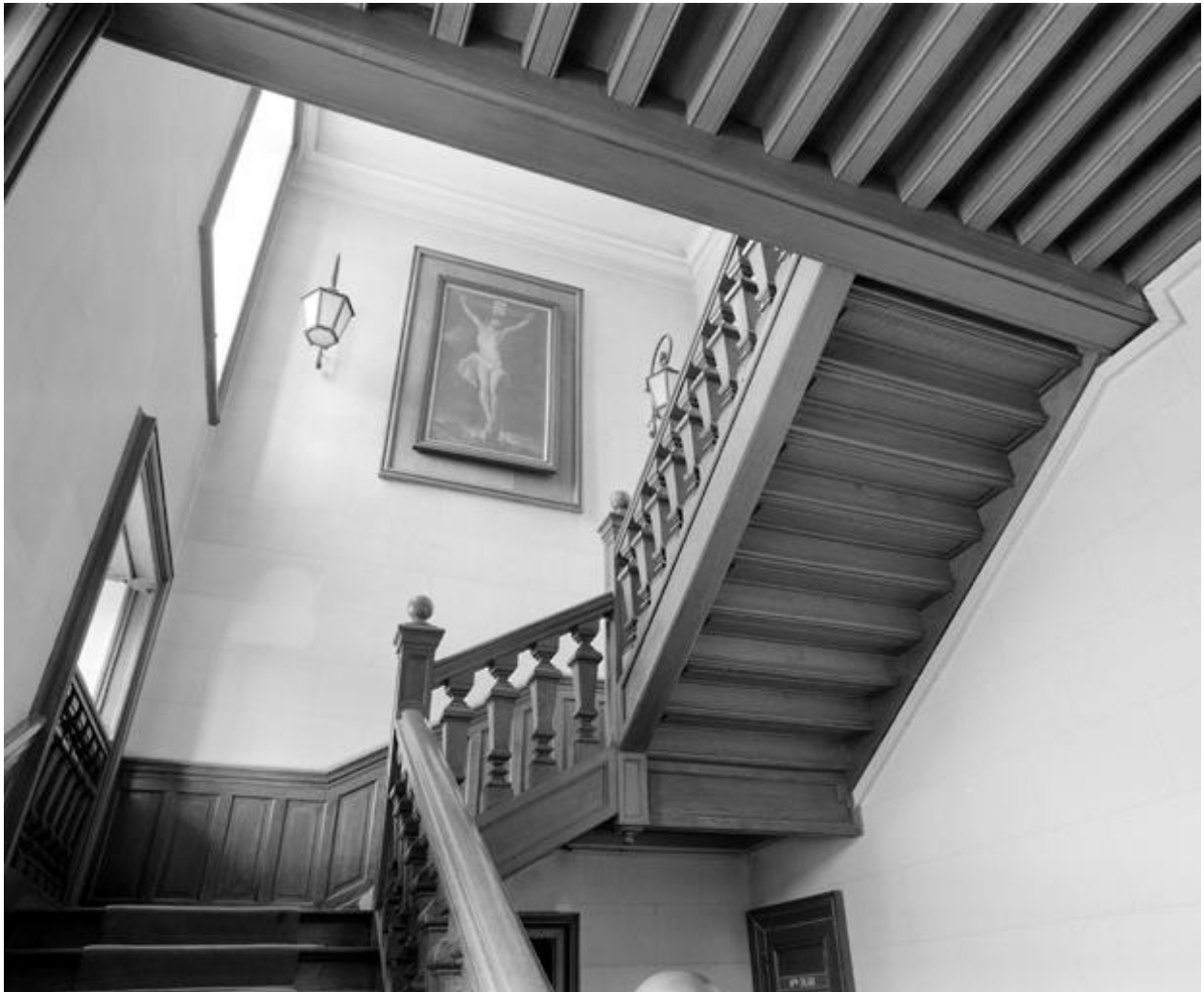
Cage de l'escalier principal (pavillon est).
