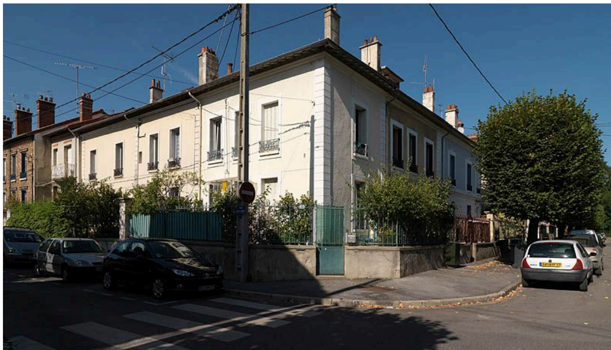
Lotissement de pavillons en bande à l'angle de la rue Ambroise-Bully et de la rue Gambetta.
