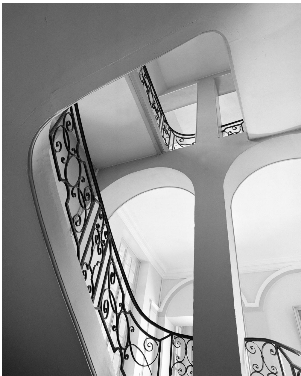
Vue en contre-plongée de la cage d'escalier entre les 1er et 2e étages.
