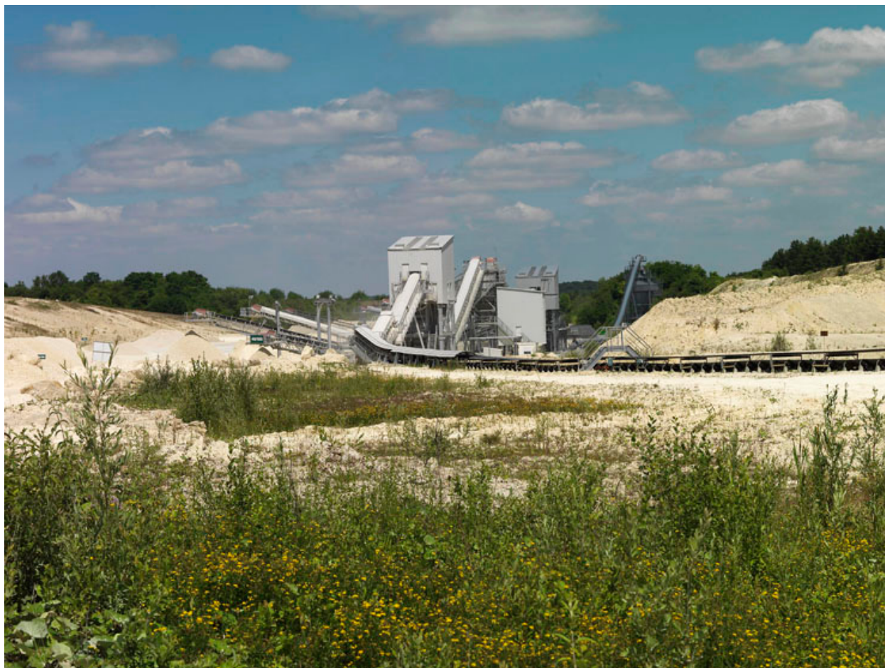
Plateforme - installation secondaire. Transporteur de plaine
