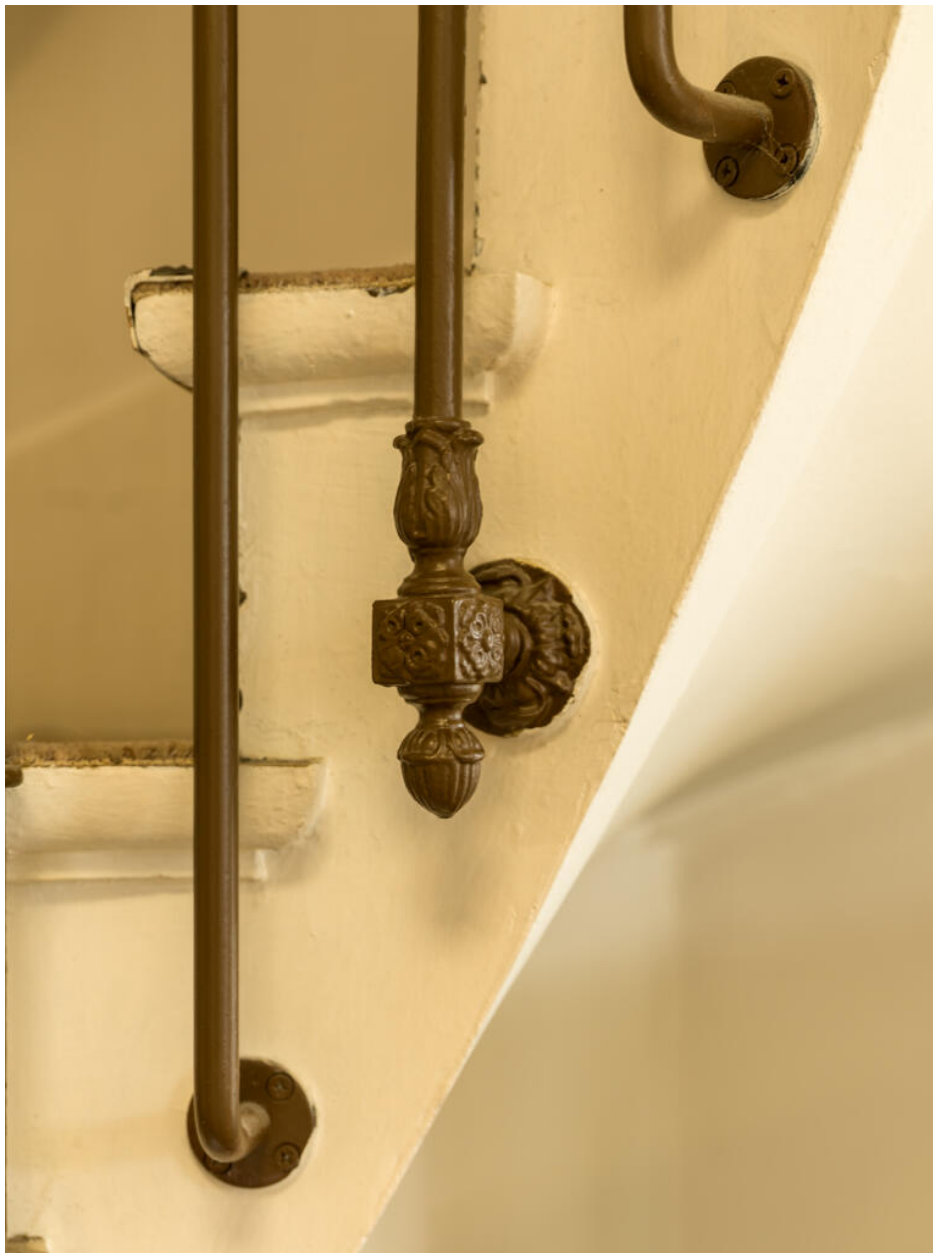
Détail de la rampe.
