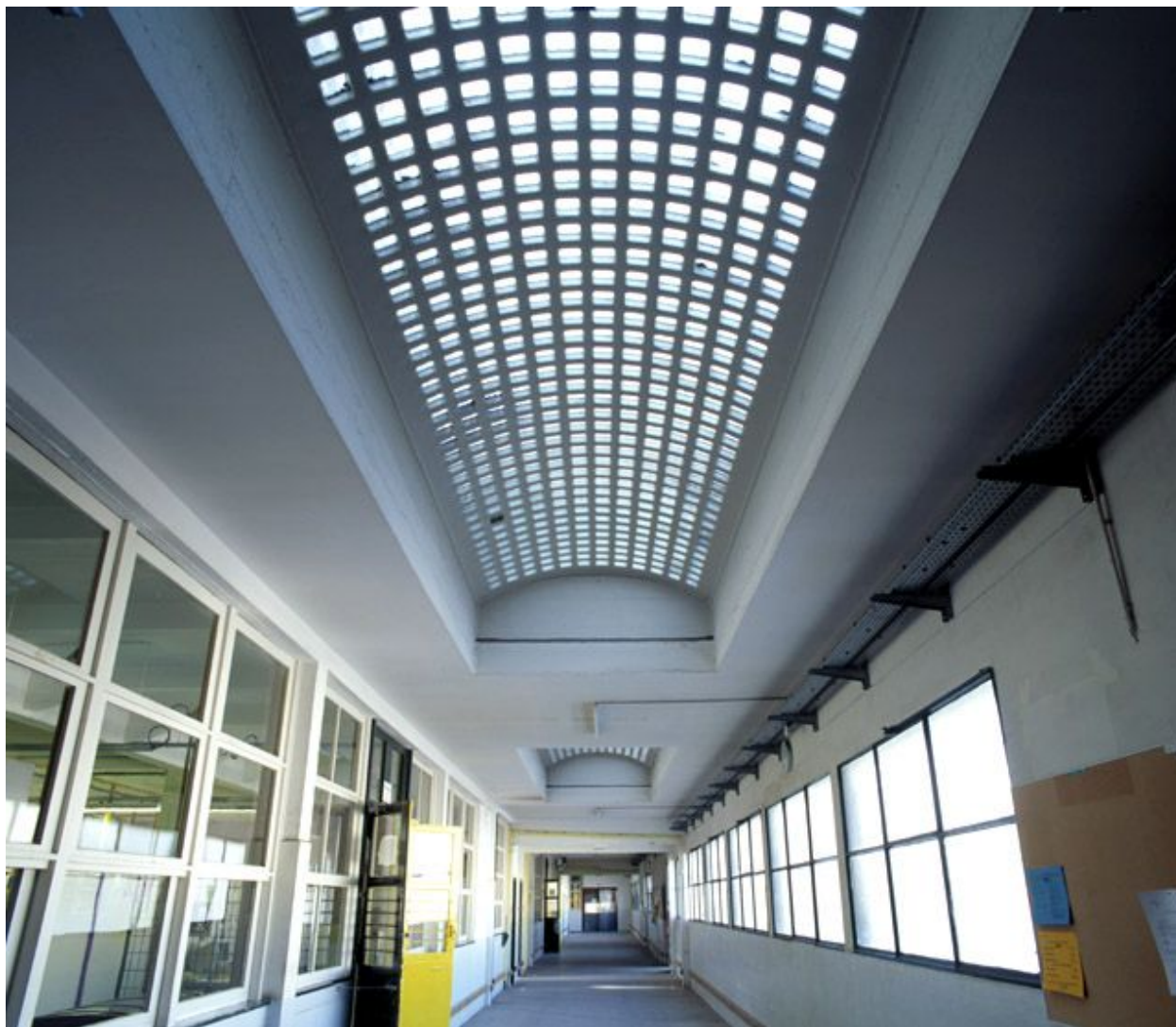
Aile sud (conditionnement) : vue générale du couloir, avec verrière zénithale.
