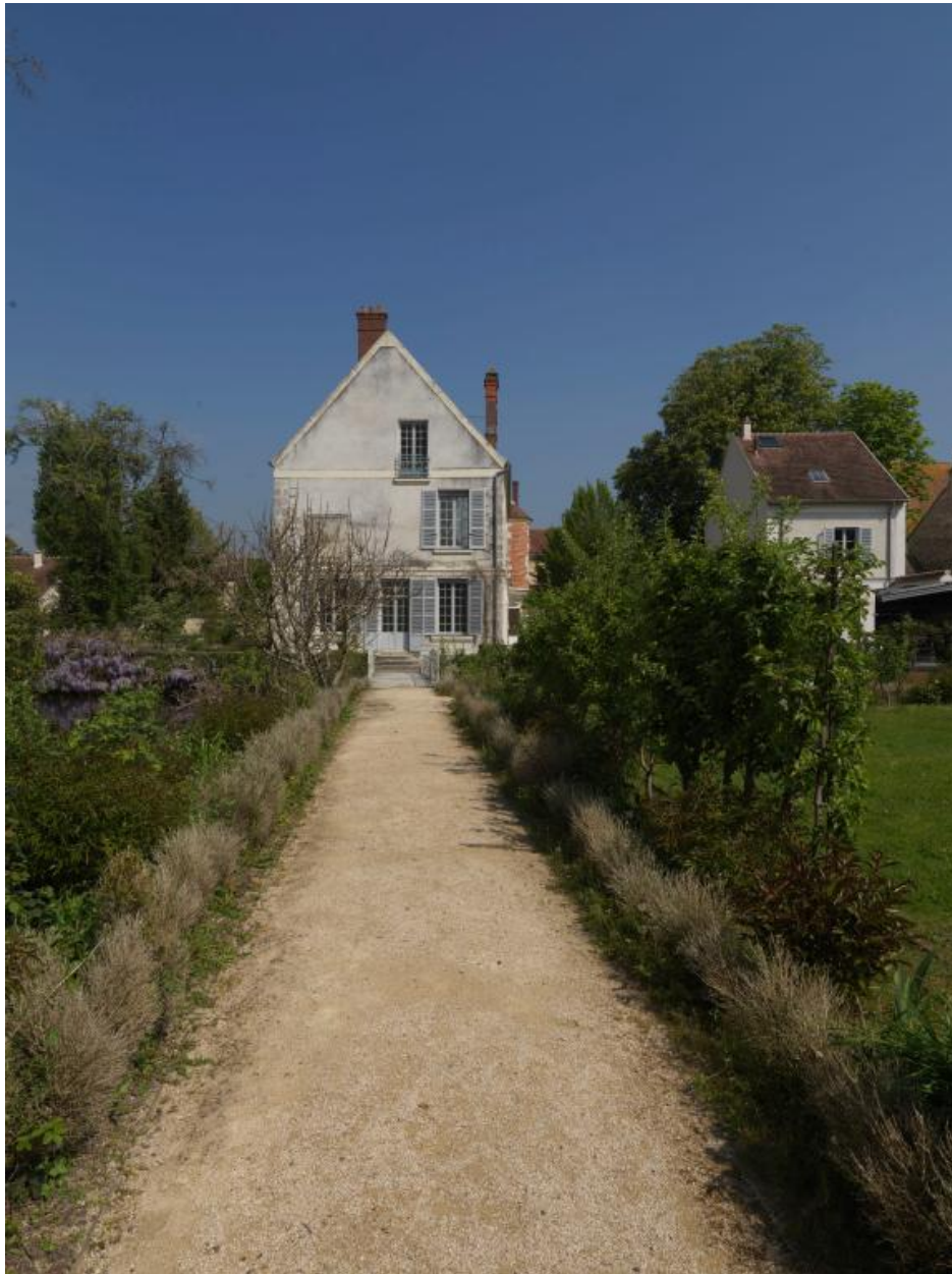
Vue du mur pignon du bâtiment principal (2)
