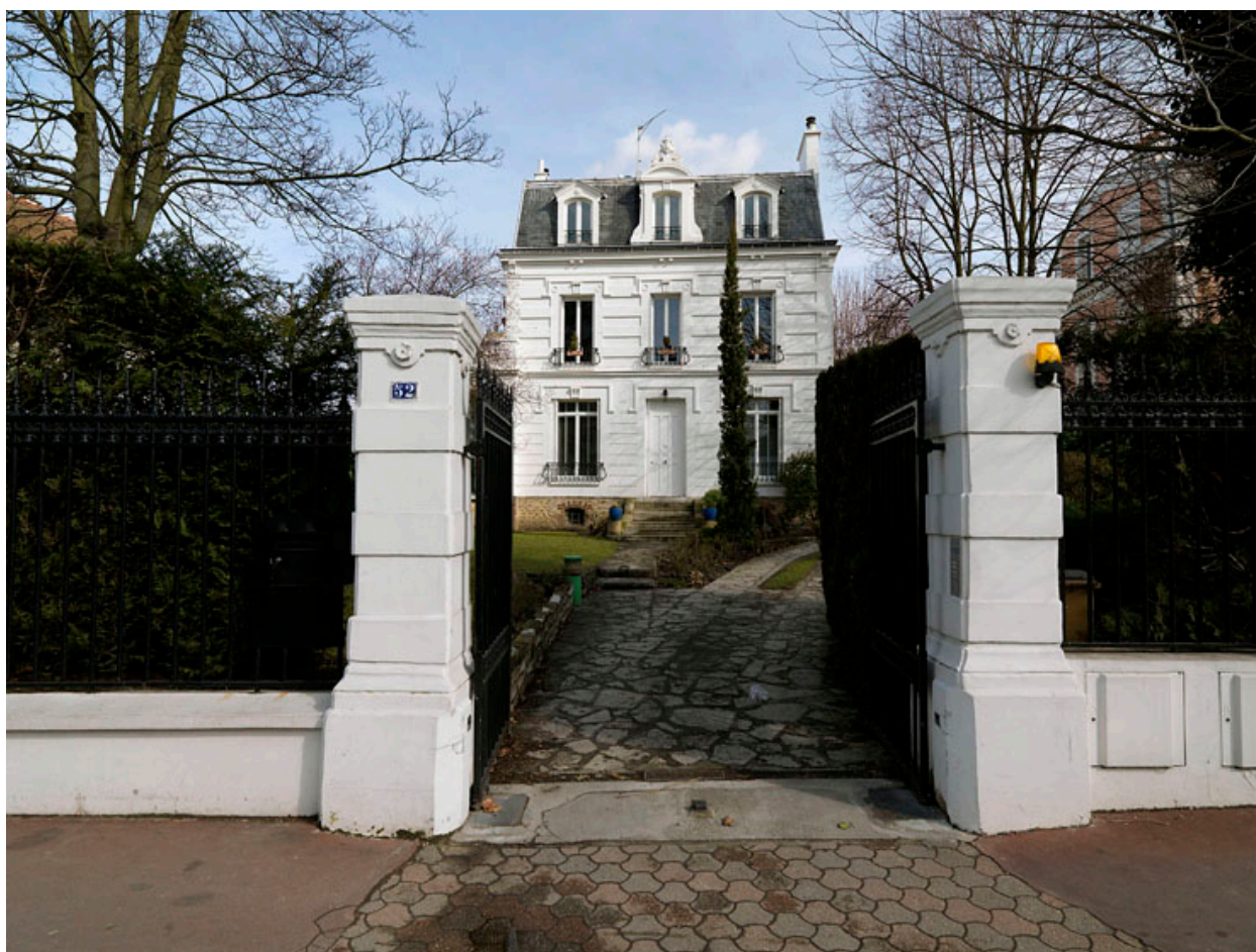
Vue d'ensemble depuis la rue : façade antérieure.
